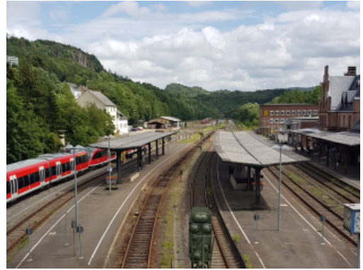
Bahnhof Gerolstein vor dem Umbau und der Hochwasserkatastrophe
