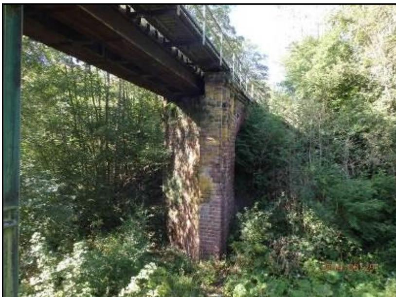
**Bauwerksbeschreibung:** Mauerwerkspfeiler aus Sandstein mit oberseitig angeordneter Festlagerkonstruktion
