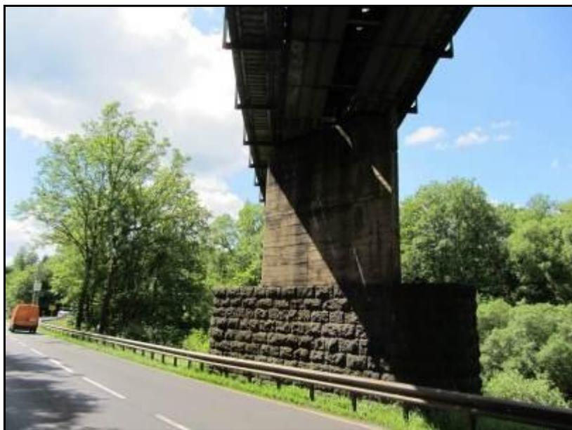
**Bauwerksbeschreibung:** Stampfbetonpfeiler (natursteinverkleidet) mit aufgesetztem Stahlbetonpfeiler
