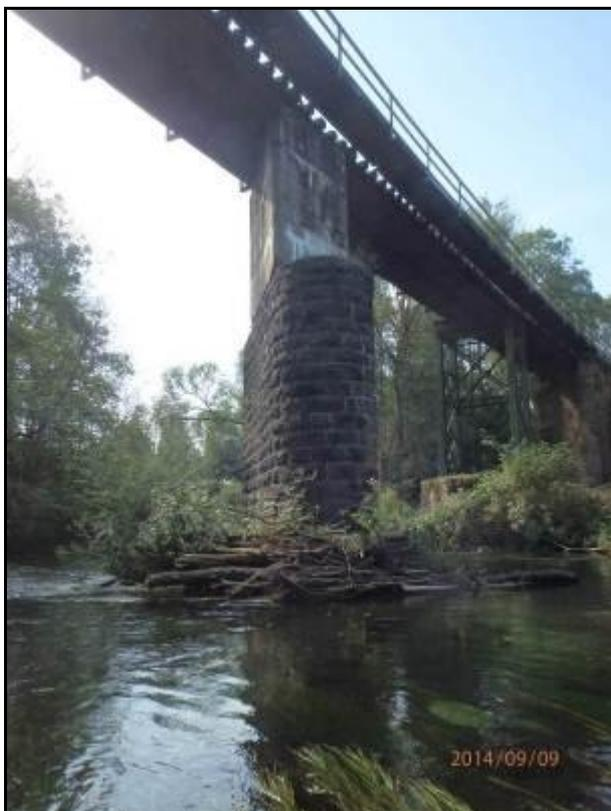
**Bauwerksbeschreibung:** Stampfbetonpfeiler (natursteinverkleidet) mit aufgesetztem Stahlbetonpfeiler
