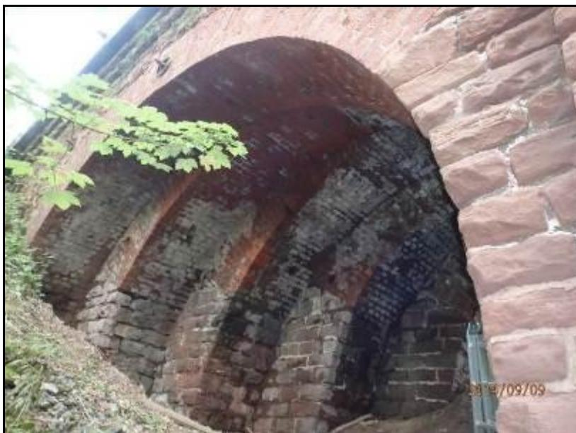
**Bauwerksbeschreibung:** Widerlager aus Natursteinmauerwerk mit aufgesetzten Gewölbebögen
