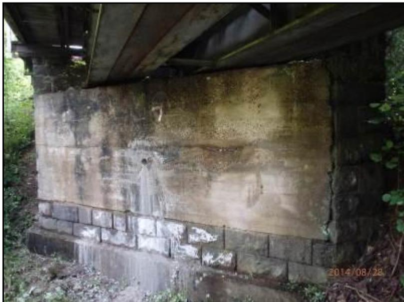
**Bauwerksbeschreibung:** Stahlbetonkern mit teilweiser Natursteinummantelung
