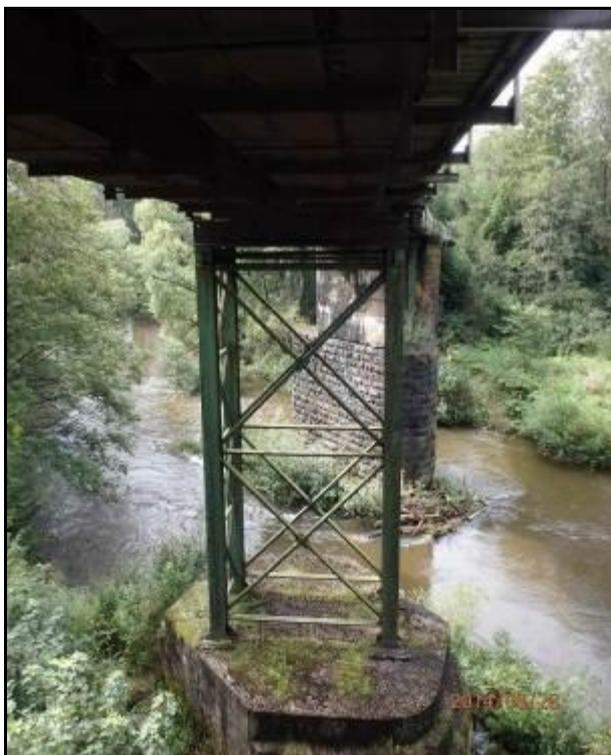
**Bauwerksbeschreibung:** Stahlbetonfundament mit Stahl-Fachwerk-Konstruktion als Bauwerkspfeiler (Schaft)
